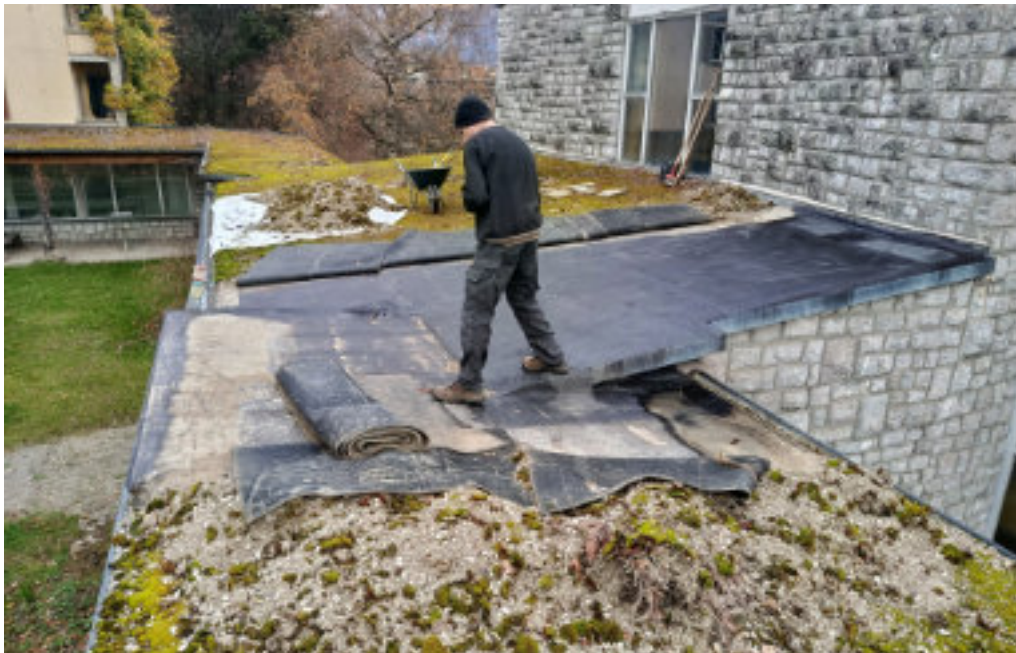
Réparation de l'étanchéité du toit plat
